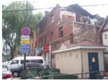
写真8 取り壊される古い集合住宅 (2017年8月31日筆者撮影)
