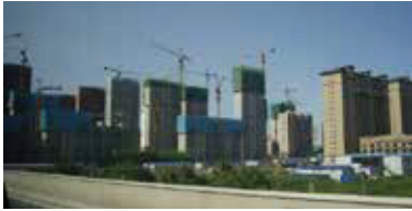
写真2 長春郊外に建設中の超高層マンション (2017年8月29日筆者撮影)
