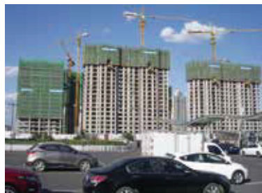
写真9 ハルビン西駅前に建設中の超高層マンション (2017年8月31日筆者撮影)
