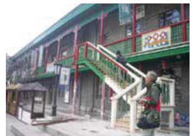
写真15 南頭道街建物の中庭の修復 (2017年9月1日筆者撮影)
