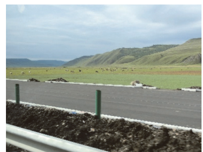
写真24 高速道路の片側2車線化工 事が進む内蒙古自治区 (2018年8月29日筆者撮影)
