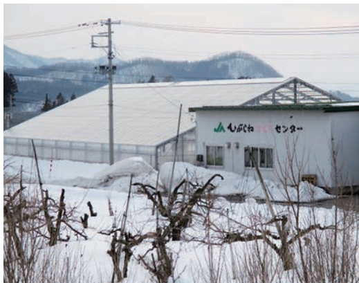
写真10 高崎地区関山にある「さくらセンター」 (右は作業室、左は促成室) 17. 3. 1撮影
