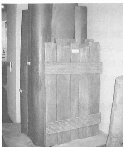
図14 尼寺廃寺（北廃寺）塔心柱・添柱・根巻き板復原模型（香芝市二上山博物館）
