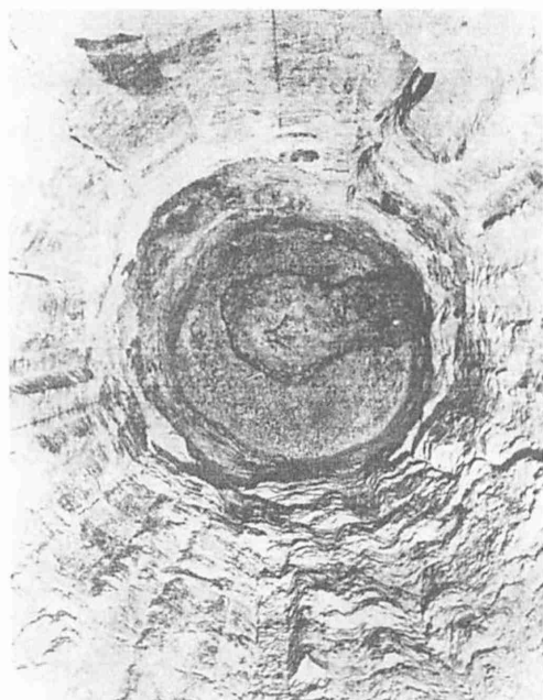
図6 法隆寺五重塔空洞に残存する 根巻き板圧痕と地下式心礎
