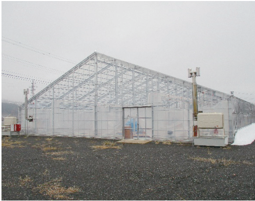
写真4 西川町にある啓翁桜促成室 17. 11. 23撮影
