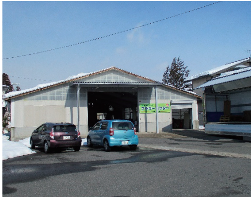
写真7 JAさがえ西村山フラワーセンター 19. 2. 12撮影
