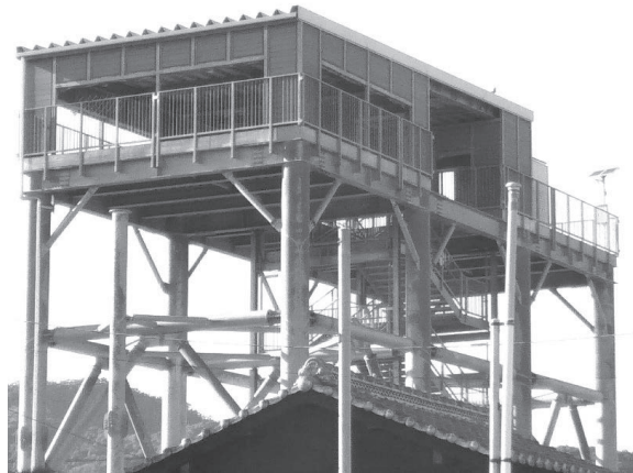
図6；高知県黒潮町に整備されている津波避難タワー（原図、2020年2月筆者撮影）
