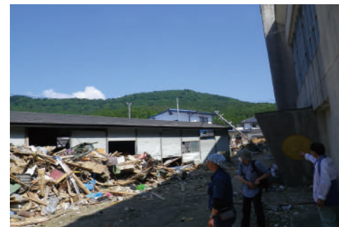
鮎川収蔵庫 被災状況
