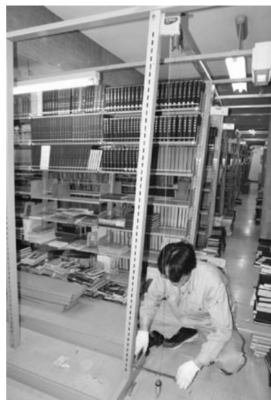
写真5 中央図書館 ゆがみ計測
