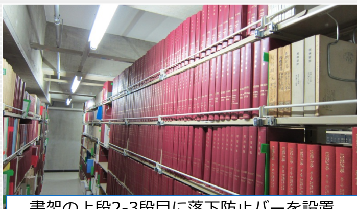
書架の上段2-3段目に落下防止バーを設置
