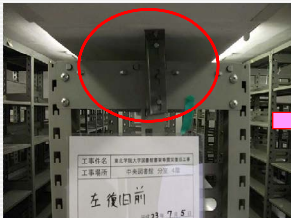
従来の「点」で支えていたボルトに加え「面」で支えるボルトを追加
