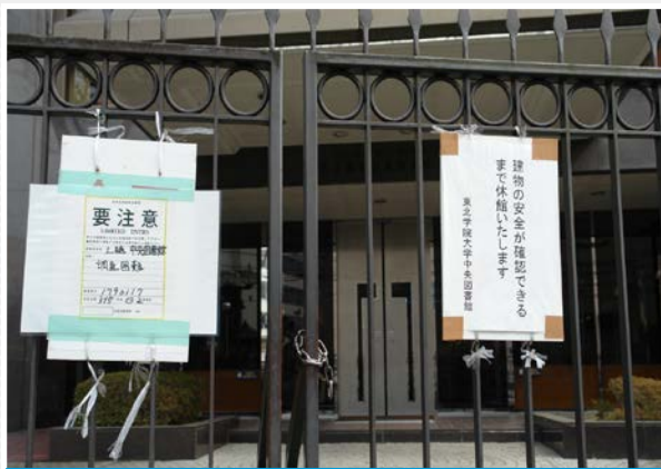
中央図書館の門扉に貼られた建物診断結果用紙には「調査困難」の文字が
