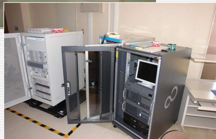
左側：免震装置付き 右側：免震装置なし
