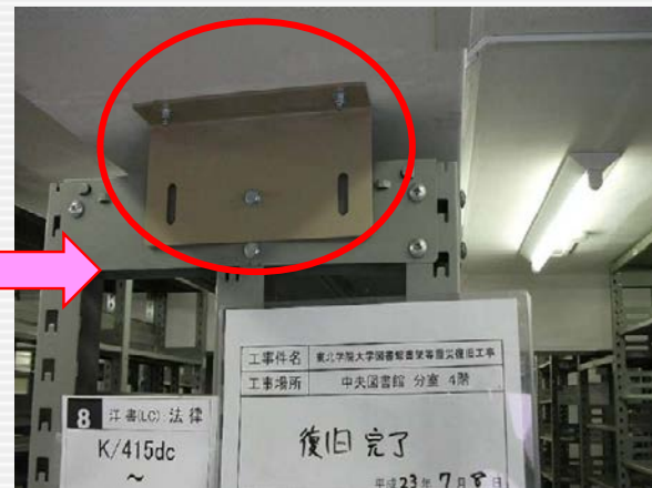
従来の「点」で支えていたボルトに加え「面」で支えるボルトを追加
