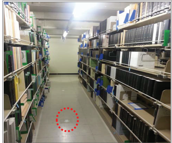
図6：「資料を落とさない場所」として避難経路沿いの書架は全段に落下防止バーを設置（床面に非常口誘導用蓄光テープを貼付。白く発光する。）
