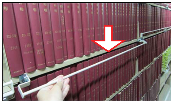
図1：書架上段2-3段目に落下防止バーを設置
