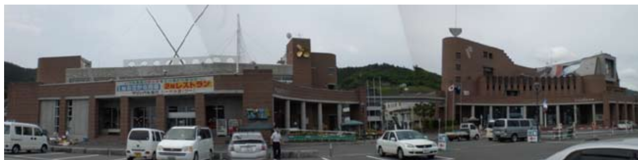
写真1 正面（海側）からみたマリパル女川の全景
