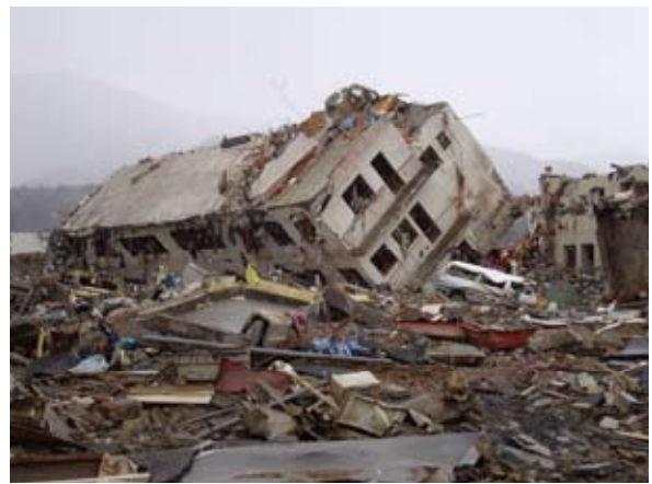
写真5 土台ごと引き剥がされたビル (2011.3.18)
