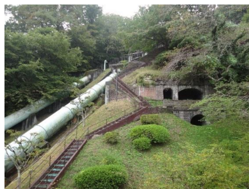
図10 三居沢発電所水路
